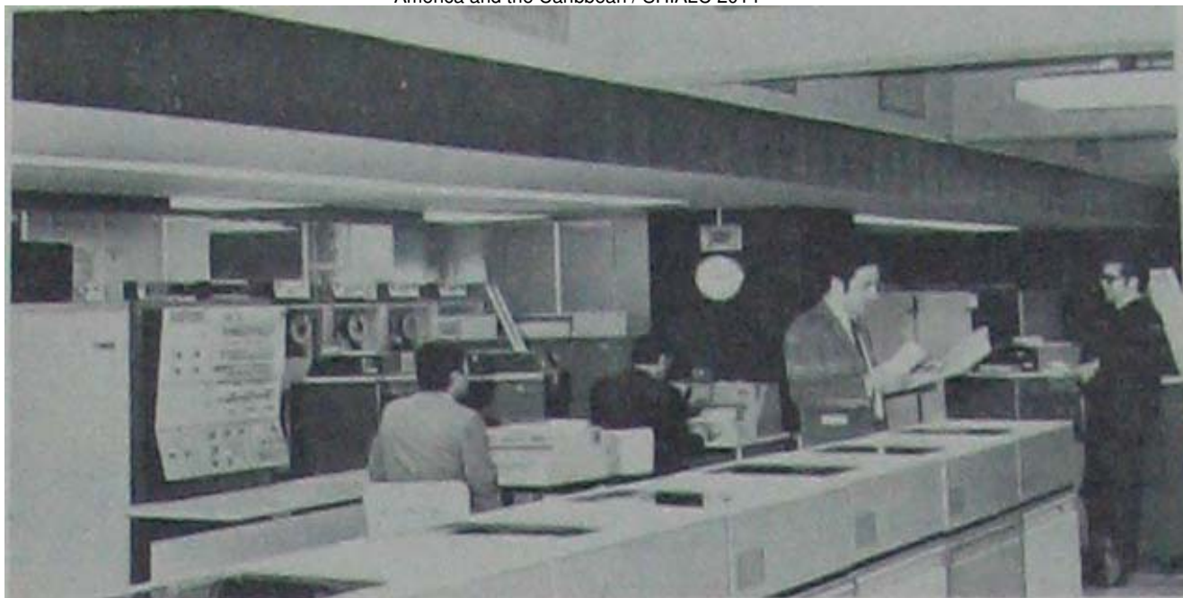
Figura 3. Instalación de EMCO en 4º piso de Edificio de Caja de Empleados Particulares
